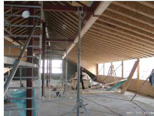
Dachkonstruktion aus Holzstegträgern
