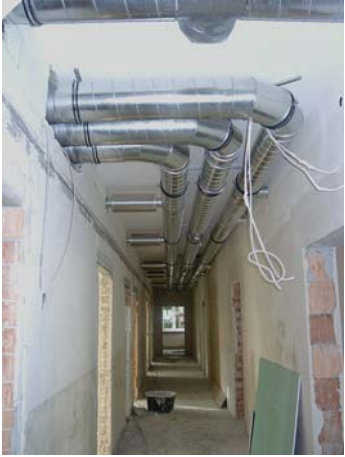
Kanalsystem Zu-Abluftanlage
