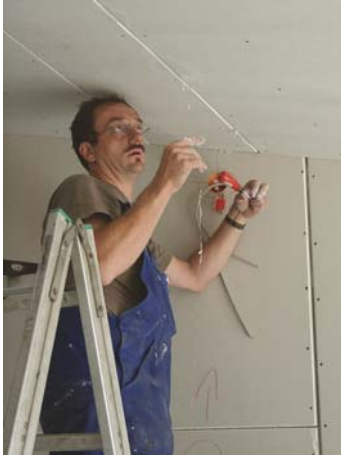
Installation von Messfühlern
