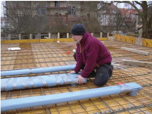
Einlegen der Lüftungsrohre in die Betondecke
